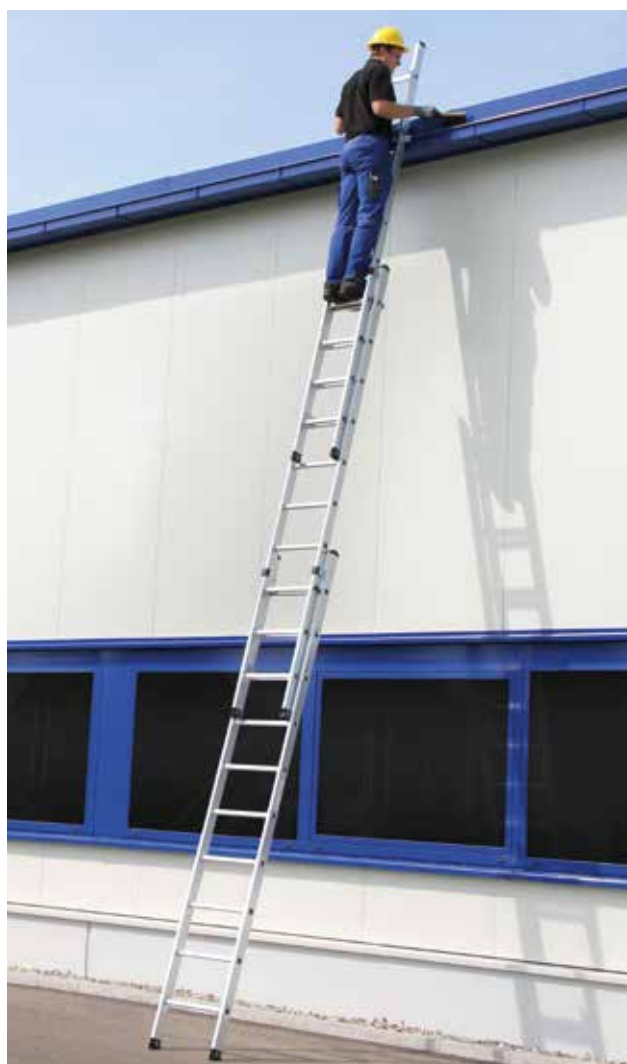
Photo n° de commande 20310, fixation de l'échelle avec des supports pour gouttière gouttière
