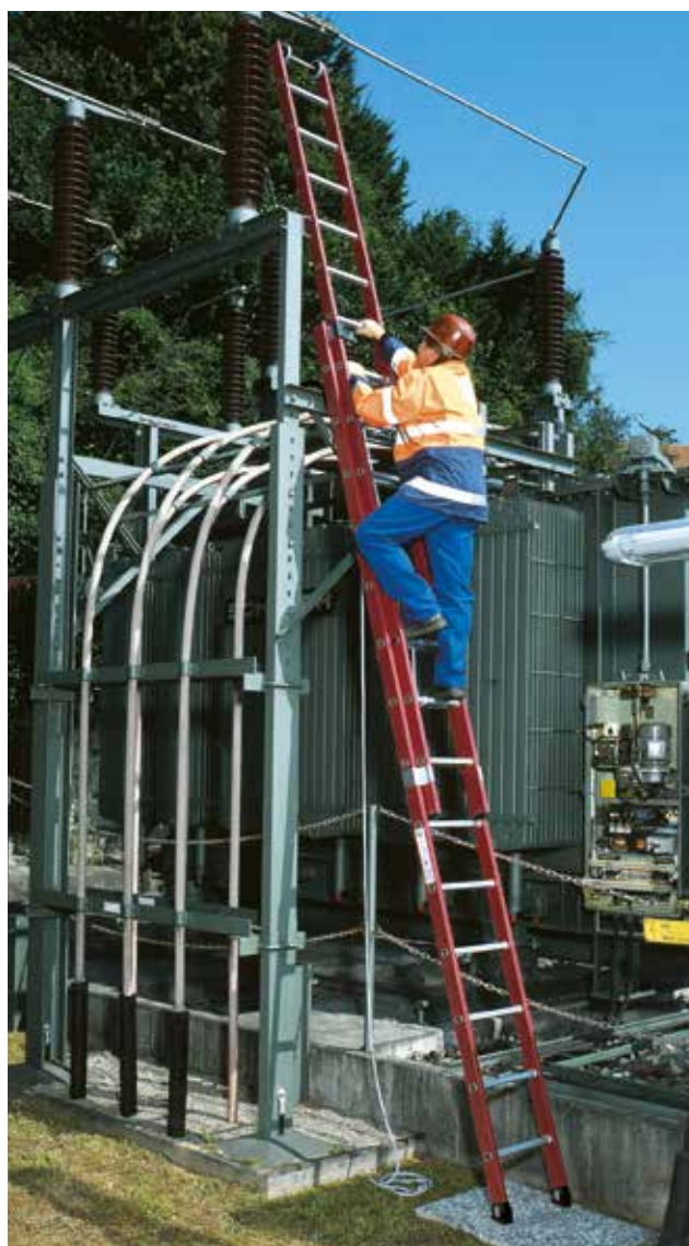
Photo n° de commande 35214, fixation de l'échelle avec des crochets
