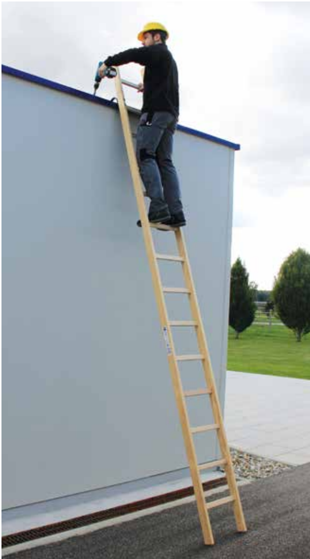
Photo n° de commande 33114, fixation de l'échelle avec des crochets
