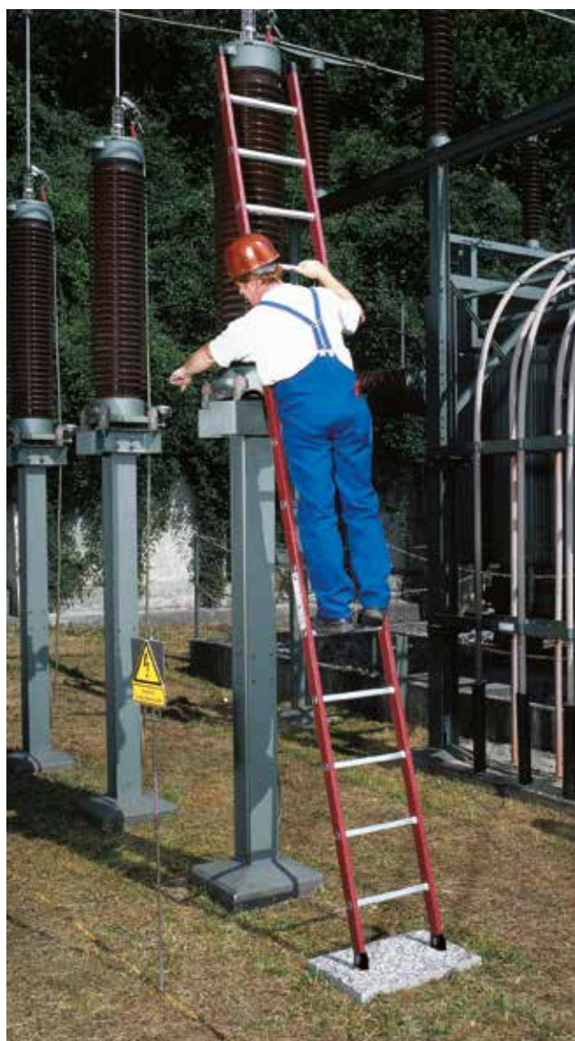
Photo n° de commande 35014, fixation de l'échelle avec des crochets
