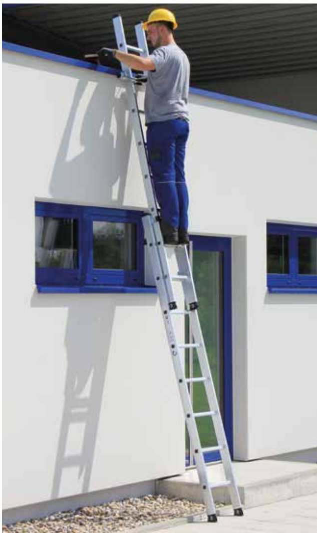
Photo n° de commande 20208, fixation de l'échelle avec des supports pour gouttière gouttière
