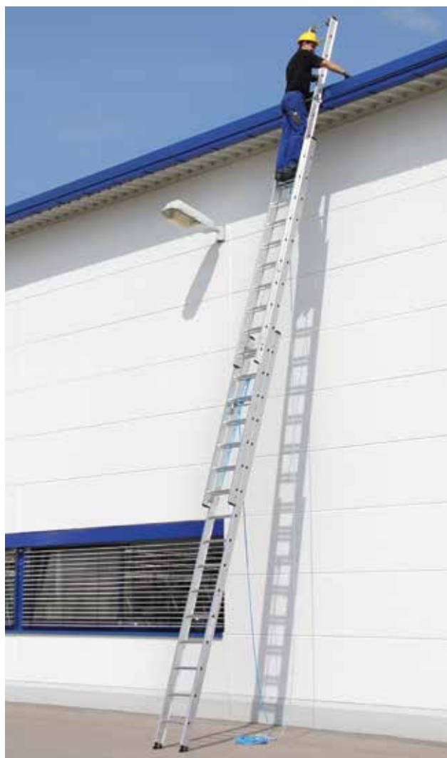
Photo n° de commande 22316, fixation de l'échelle avec des supports pour gouttière gouttière
