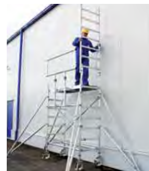
Sécurisée par le garde-corps "de tête", la plateforme est accessible sans danger et le montage de l'échafaudage peut être poursuivi. Le garde-corps de sécurité de montage est à nouveau placé "en tête" pour les plates-formes suivantes avant de monter au niveau supérieur.
